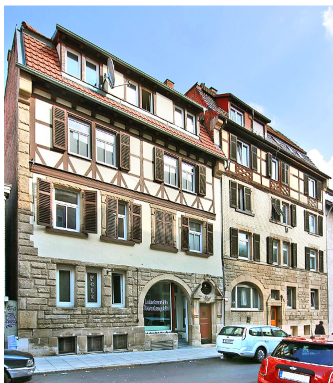
Doppelmiethaus Taubenstraße 3/5, errichtet 1901.
