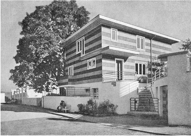
Das »Typenhaus E. T. 27« hat Walther Rist nach Bauhaus-Lehren entworfen. Das Gebäude im Pankokweg 13 am Rand der Weißenhof-Siedlung wurde »ausser Programm auf der Werkbund-Ausstellung 1927« gezeigt.
